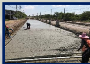
งานเทคอนกรีตแผ่นพื้นสำหรับ Bearing Slab โครงสร้าง ใต้คันทาง ช่วงกม. 14+399 ถึง กม.14+499 LT, กม. 16+313 ถึง กม.16+358 LT และงานผิวจราจร แอสฟัลต์คอนกรีต Binder Course ช่วง กม.14+153 ถึง กม.14+850 RT และ กม.18+225 ถึง กม.18+575 RT
