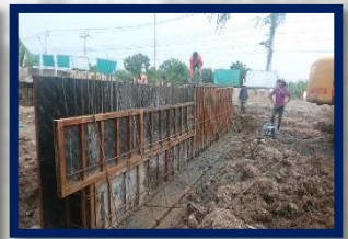
งานผูกเหล็กและติดตั้งแบบ และเทคอนกรีตคานขวาง บนเสาสะพาน ตำแหน่ง P5, P6 และ P7 สะพานข้าม คลองกระแซงเตย กม.12+361 RT และงานผูกเหล็ก เสริมติดตั้งแบบ และเทคอนกรีตต่อม่อตำแหน่ง P4 สะพานข้ามคลองสร้งบุญ กม.17+176 RT
