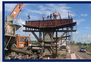
งานผูกเหล็กและติดตั้งแบบ และเทคอนกรีตคานขวาง บนเสาสะพาน ตำแหน่ง P5, P6 และ P7 สะพานข้าม คลองกระแซงเตย กม.12+361 RT และงานผูกเหล็ก เสริมติดตั้งแบบ และเทคอนกรีตต่อม่อตำแหน่ง P4 สะพานข้ามคลองสร้งบุญ กม.17+176 RT
