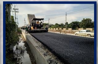
งานเทคอนกรีตแผ่นพื้นสำหรับ Bearing Slab โครงสร้าง ใต้คันทาง ช่วงกม. 14+399 ถึง กม.14+499 LT, กม. 16+313 ถึง กม.16+358 LT และงานผิวจราจร แอสฟัลต์คอนกรีต Binder Course ช่วง กม.14+153 ถึง กม.14+850 RT และ กม.18+225 ถึง กม.18+575 RT
